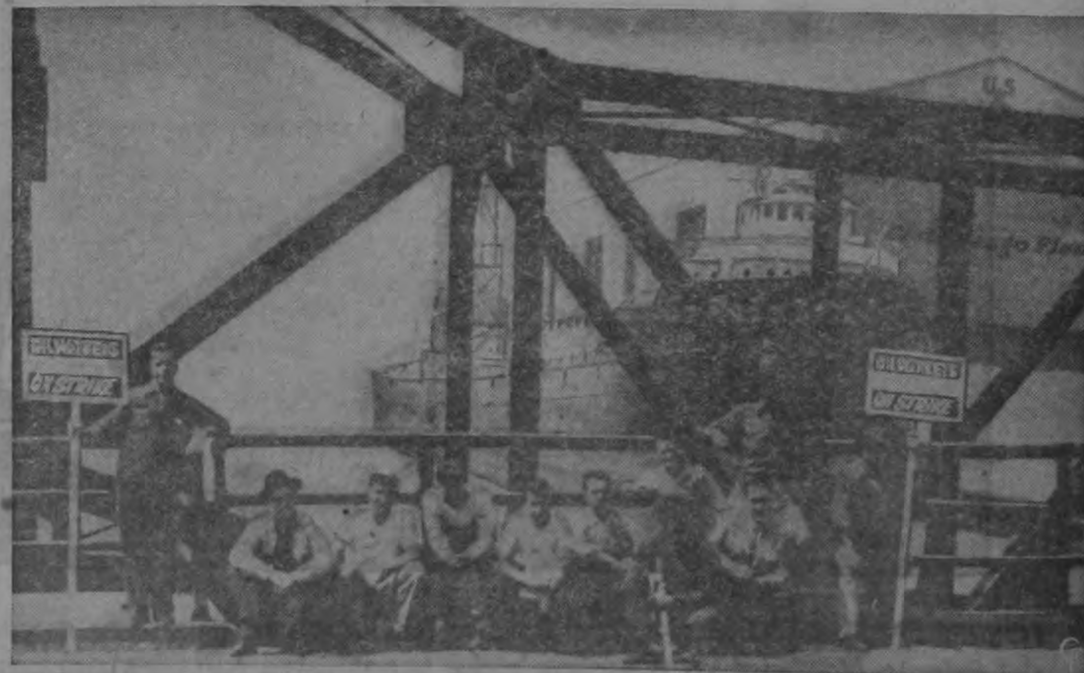
Por el tercer día consecutivo obreros petroleros en huelga se sientan sobre el puente levadizo que cruza el canal de la bahía de Indiana, en East Chicago, Indiana, y se niegan a permitir que el puente sea abierto para dar paso a los buques estanco. Al fondo se
